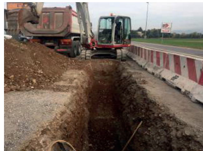
Lavori in corso per la ciclopedonale sulla Sp121
